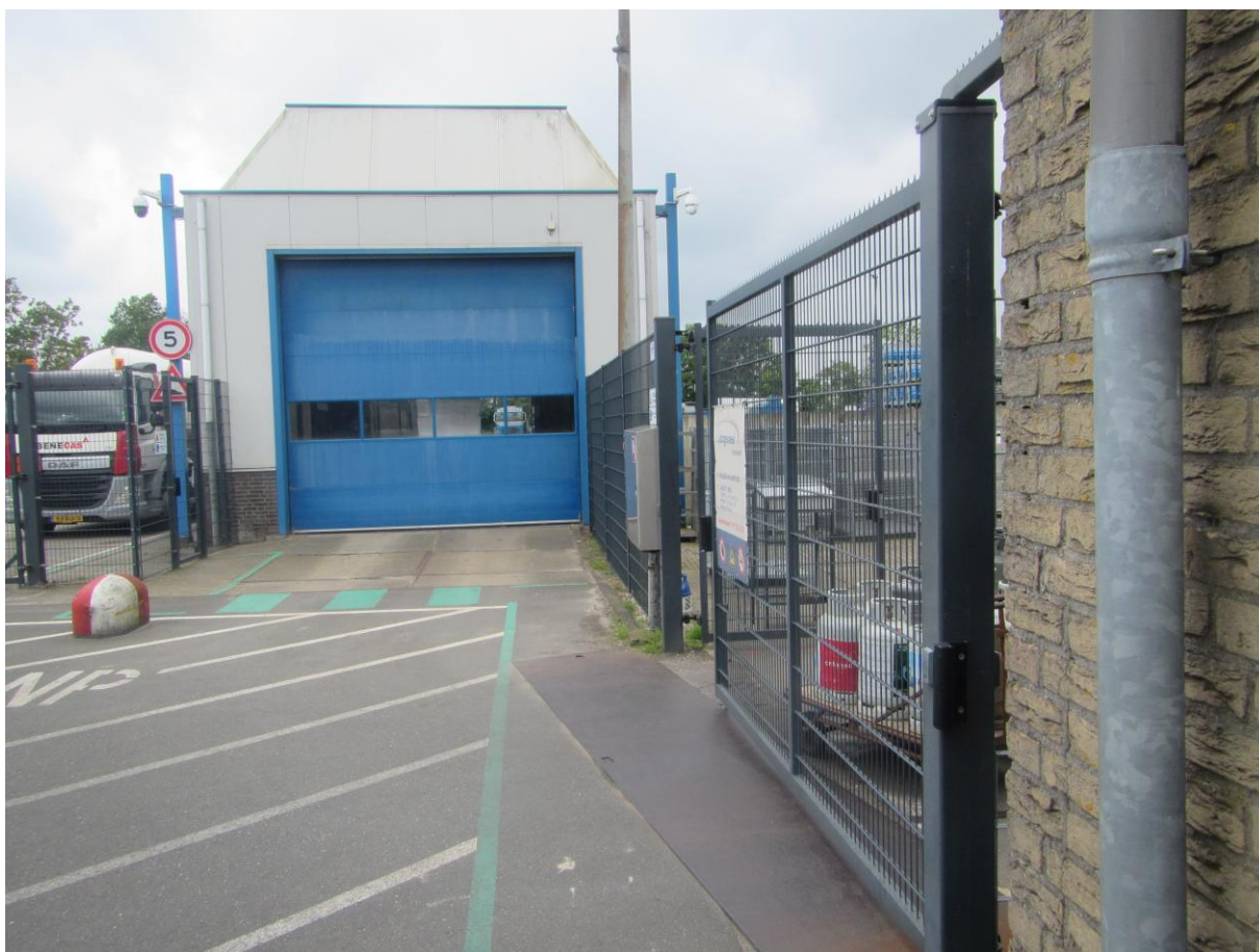
Fig. 2.: Op het wegdek aangebrachte markering ter hoogte van de nieuwe vulstation voor propaanflessen bedoeld om aan te geven dat binnen het betreffende vak geen voertuigen mogen worden geparkeerd
