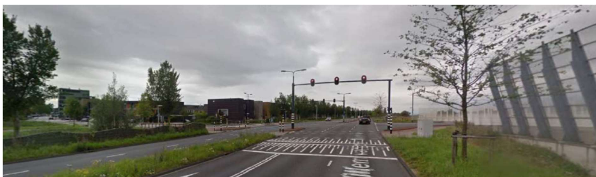
Figuur 4. Geluidschermen langs de Van der Made weg: links een (laag) gemeentelijk geluidscherm, rechts het hoge transparante scherm van de A4
